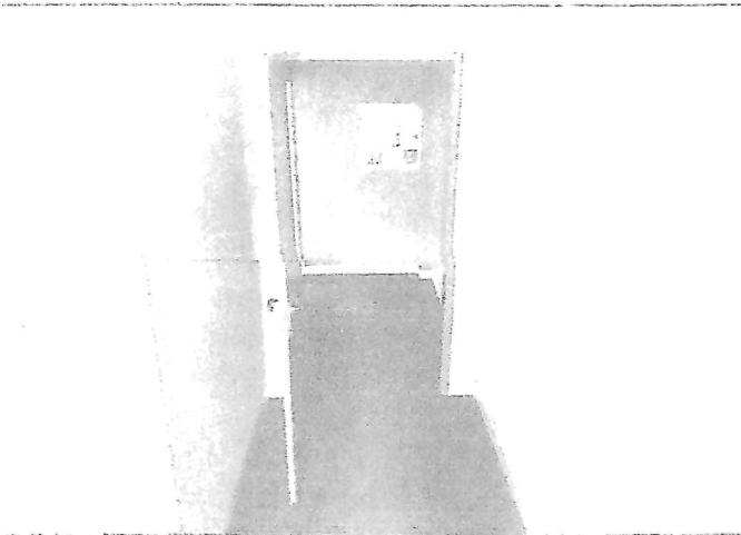
Фото №13 – Пути движения внутри здания (двери)
